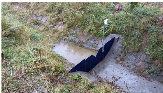
Obrázek 3.5: Monitoring povrchového odtoku na HOZ pod retenčními přehrážkami.
