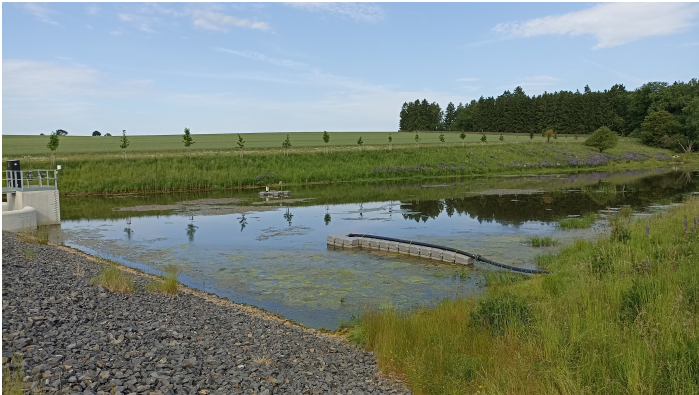
Obrázek 3.2: Výparoměr a jímací zařízení.
