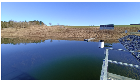
Obrázek 3.4: Malá vodní nádrž - monitoring srážek na hrázi.
